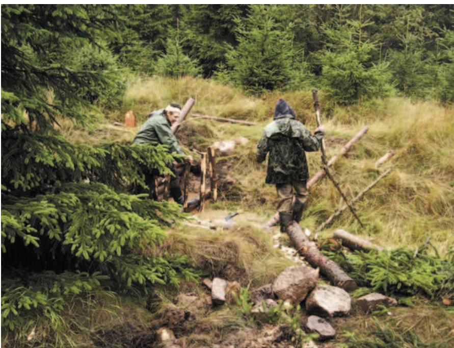
Stavba dřevěných přehrážek, které postupně zatarasí umělé drenážky a zadrží vodu.
