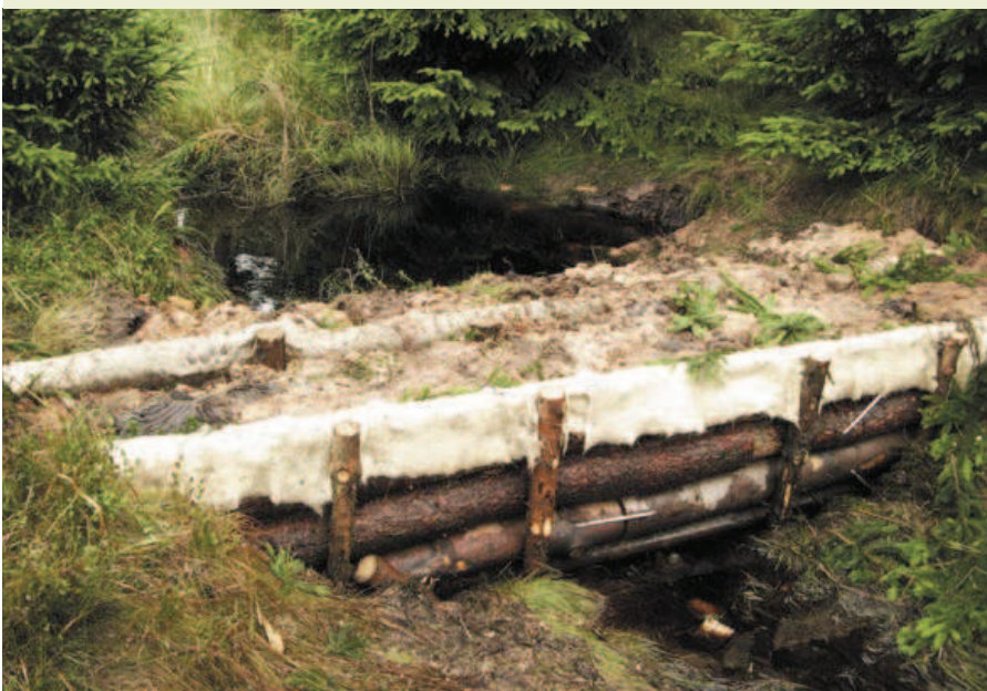
Stavba dřevěných přehrážek, které postupně zatarasí umělé drenážky a zadrží vodu.
